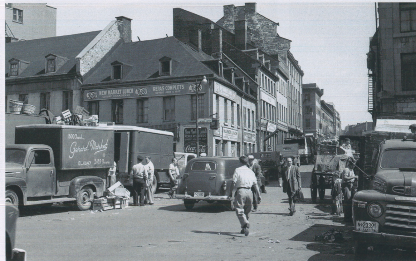
ENFANTS, HABITANTS, MARCHANDS ET TRAVAILLEURS circulent rue Saint-Paul (1952), véritable pôle au sein de la vieille ville — et première rue à bénéficier d'un éclairage public, dès 1815. Son croisement avec le Marché neuf — la place Jacques Cartier — n'y est pas étranger.
